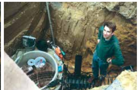
Beton menhol uygulaması.
