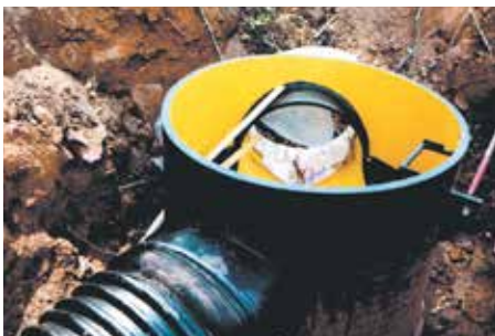
Dönüş noktasında giriş çıkışlı menhol, boru içi ark ve merdiven uygulamalı.
